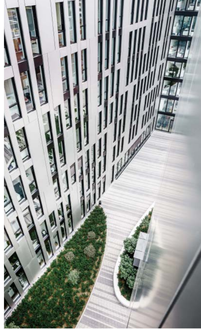
▲ Die Fassadentafeln sind unsichtbar in einer speziellen UK eingehängt
