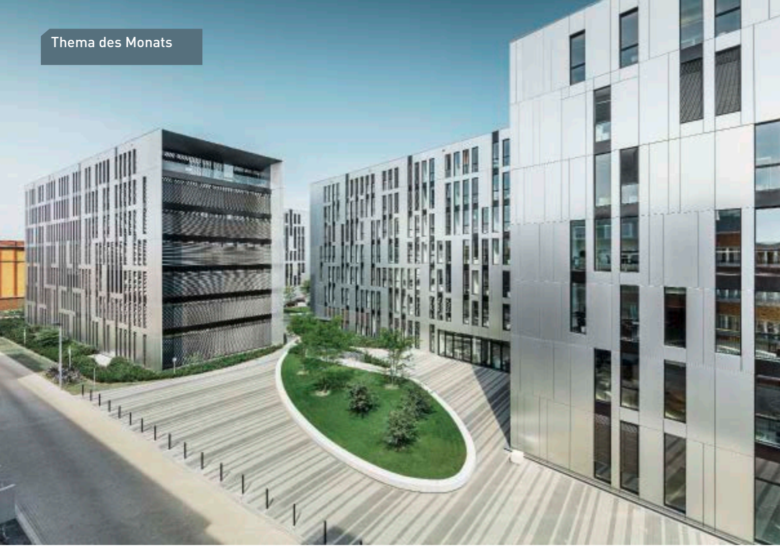
▲ Eine Fassade wie ein Instrument: Die rhythmische Anordnung der Fensterschlitze erinnerte den Bauherren an alte Musiklochplatten aus Metall
